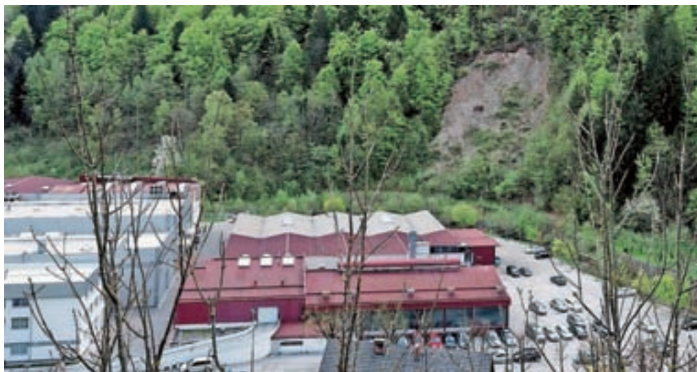
Občina Železniki in Domel se bosta letos s skupnimi močmi lotila sanacije plazov za največjim železnikarskim podjetjem. / FOTO: ANDREJ TARFILA
